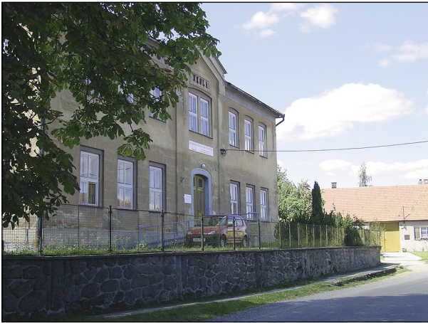
Budova Axmanovy školy pro nevidomé výtvarníky v Tasově
