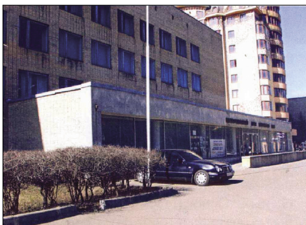
Budova Kulturního a sportovního centra VOS
